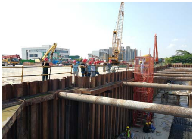
开展 2019 年度对河道管理范围内工程建设项目实地检查
